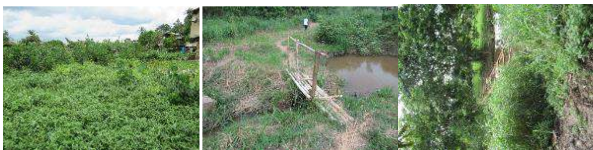
Vue de quelques zone de bassins versant et de traversées de fortunes au quartiers Potos et Corneille
