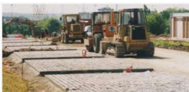
Illustration des Travaux de pavage des voiries
