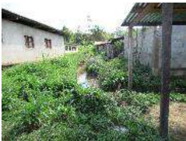
Système de canalisation de fortune (absence de curage) et dépôt sauvage d'ordures ménagères source d'inondation
