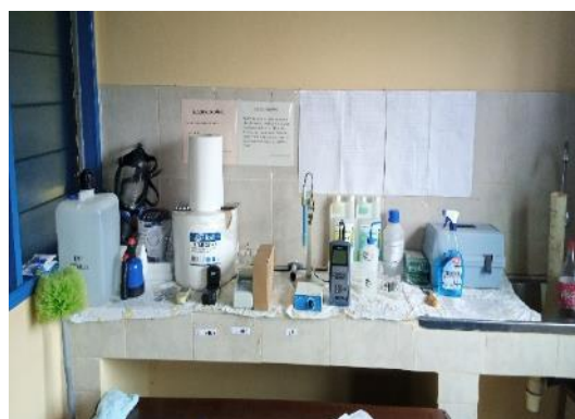
Photo 81 : Vue de la station de traitement d'eau à Médouneu (b)
