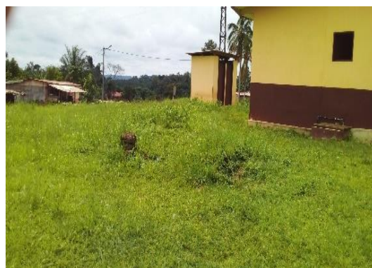
Photo 19 : Vue des sanitaires hors d'usage de l'école publique
