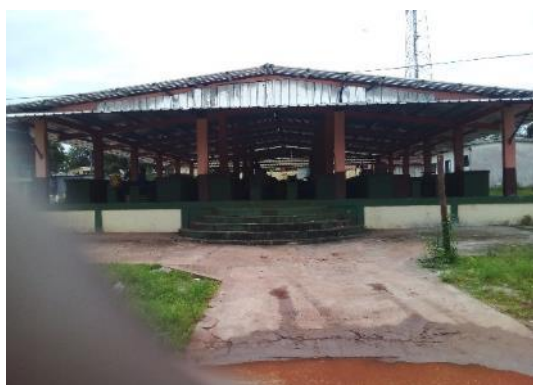
Photo 46 : Vue du marché communal de Gamba au quartier Plaine 3 (a) (Source : BNETD, 2021)
