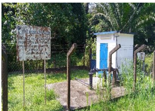
Photo 29 : Vue du Forage F2 de Cocobeach
