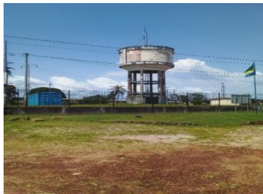
Photo 51 : Vue du château d'eau à Gamba
