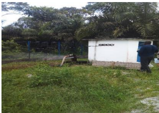
Photo 50 : Vue d'un forage à Gamba
