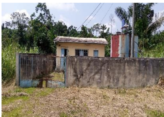
Photo 85 : Vue de la station de traitement de Minvoul (a)
