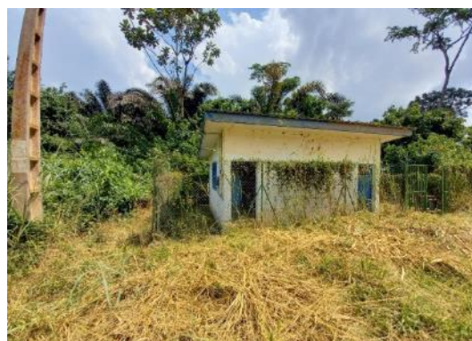
Photo 86 : Vue de la station de traitement de Minvoul (b)
