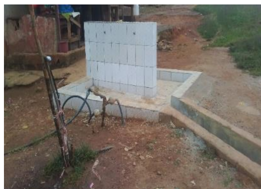
Photo 16 : Vue des travaux de réhabilitation d'une pompe hydraulique par le Comilog à Bakoumba
