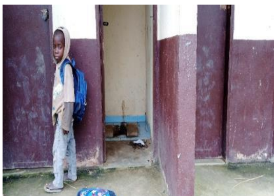
Vue des toilettes de l'école communale A à réhabiliter
