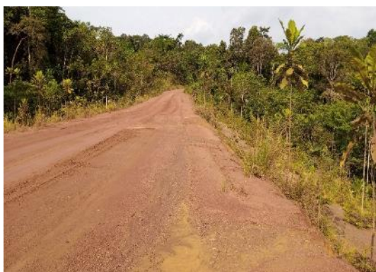
Photo 1 : Vue de la voie d'accès de la localité de Médouneu
