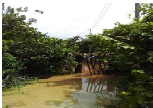
Visite du site de l'entrée des installations, à la base de la SEEG à Ndendé
