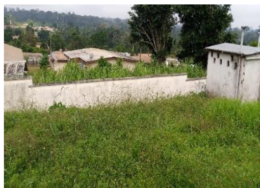
Vue du site des toilettes du centre de santé à construire
