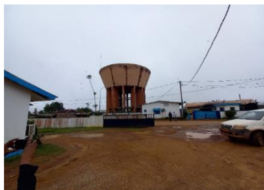
Photo 65 : Vue du château d'eau à Makokou
