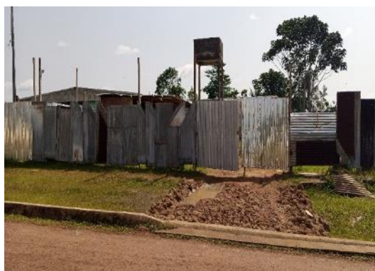
Photo 82 : Vue du centre de santé en cours de réhabilitation
