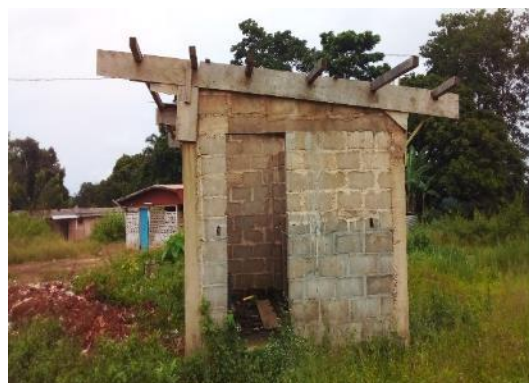
Vue des travaux inachevés de construction d'un sanitaire
