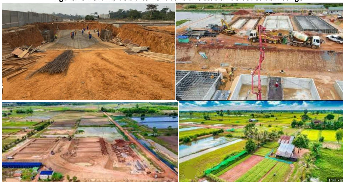
Planche photos 30 : Images illustratives d'une STBV en phase de construction
