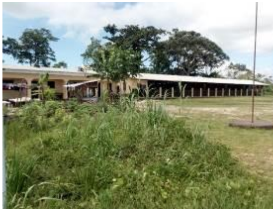
Photo 11-vue de maison en parpaing (dure) à Iwosso
