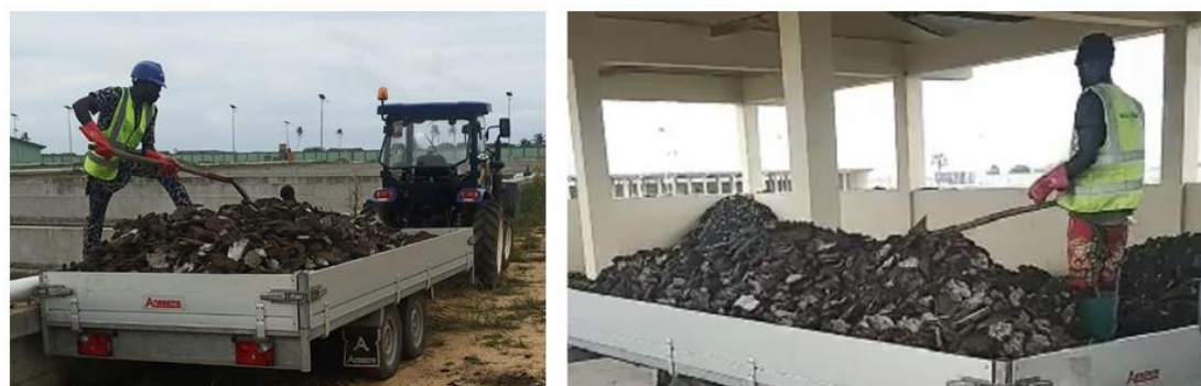
Planche photos 31 : Images illustratives d'une STBV en phase d'exploitation : dépôt, décantation, sédimentation, lagunage, séchage et enlèvement des boues.
