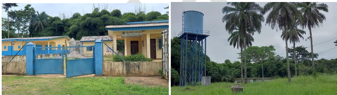
Figure 28 : Station d'eau potable à Mékambo.
