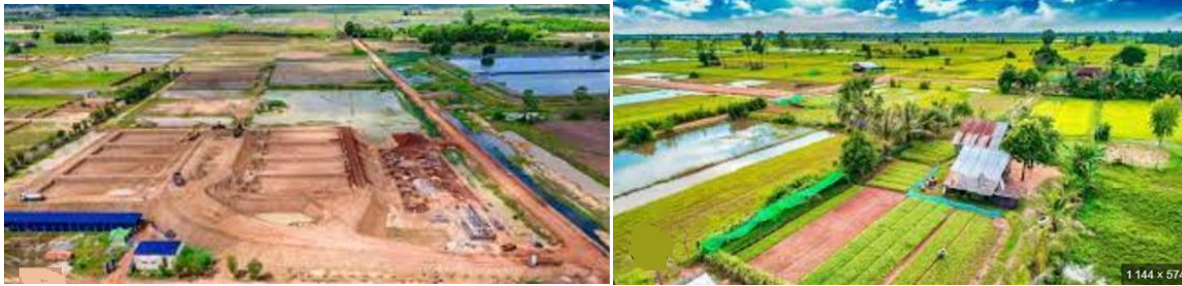
Planche photos 30 : Images illustratives d'une STBV en phase de construction
