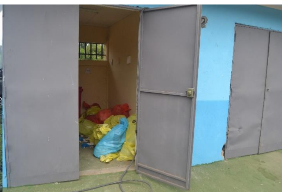
Local de stockage des déchets biomédicaux à l'hôpital Egypto-gabonais
